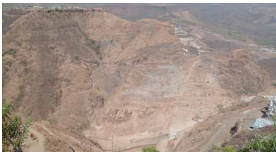
Foto sotto Scavi della spalla destra della diga di Gibe III in Etiopia.
